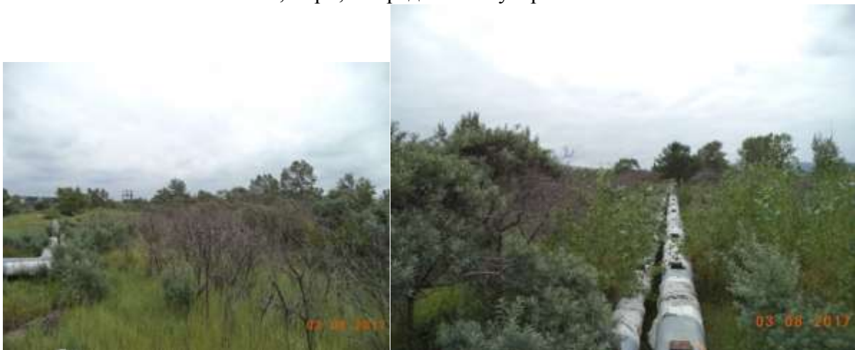
Рисунок 2.24 – Около территории проходит трубопровод
